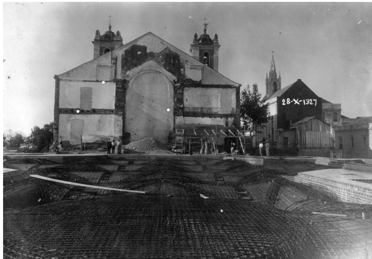
▲ Foto 68. [28/10/1927] Ferragens da estrutura do entrepiso que cobre a cripta. Ao fundo, rente ao que restou de velha matriz, os insumos do concreto que em breve serão espalhados sobre a ferragem. Em primeiro plano, a caixaria de madeira abaixo dos ferros moldará as abóbadas e arcos com caixotões que adornam o teto da cripta.
