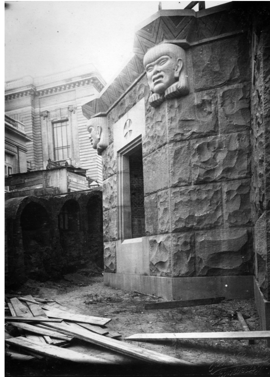
▲ Foto 12. À esquerda na imagem, um dos arcos que estruturavam as rampas escalonadas da rua Dom Sebastião.
