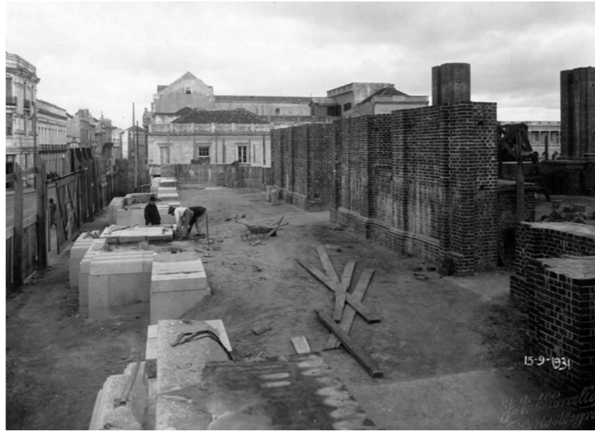
► Foto 79. Construção do pódio que eleva o átrio em relação à rua Duque de Caxias. Na parte direita, as paredes de alvenaria que dividem o átrio da nave. Sob supervisão do Mons. Balem, pedreiros assentam pedras que servirão de base para as colunas monolíticas e formarão o pórtico principal de acesso.
