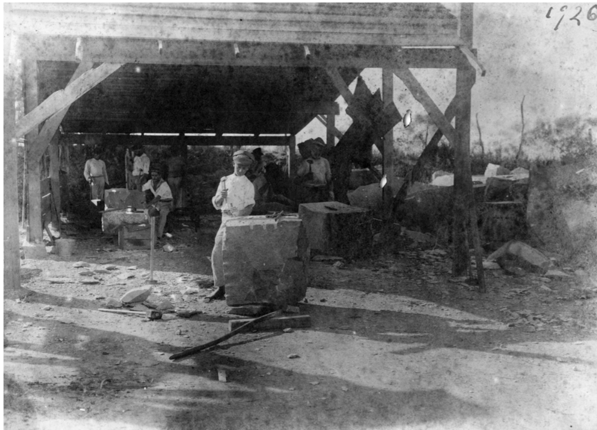
▲ Foto 15. [1920] Oficina de cantaria sob telheiro de zinco. Canteiro menino usa bujarda e talhadeira para lavar um bloco de granito. Em 1920, Mons. Balem e José Brunelli, antigo morador do arrabalde de Teresópolis, percorreram aquelas imediações e visitaram algumas pedreiras. A fotografia, provavelmente, foi retratada durante a visita a alguma delas.
