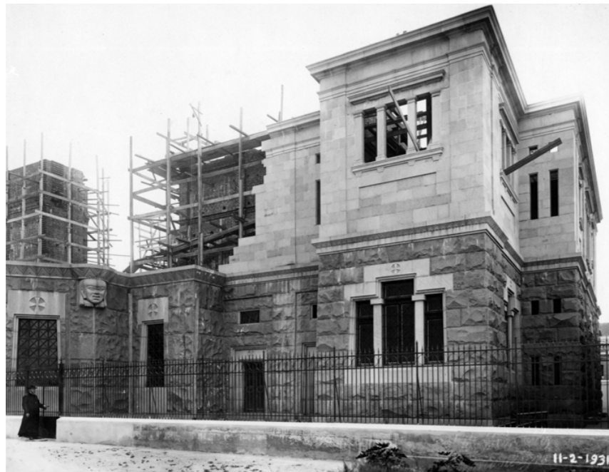
▲ Foto 77. Construção das sacristias e interior da nave. Entre os andaimes, os pilares que sustentarão a grande cúpula.
