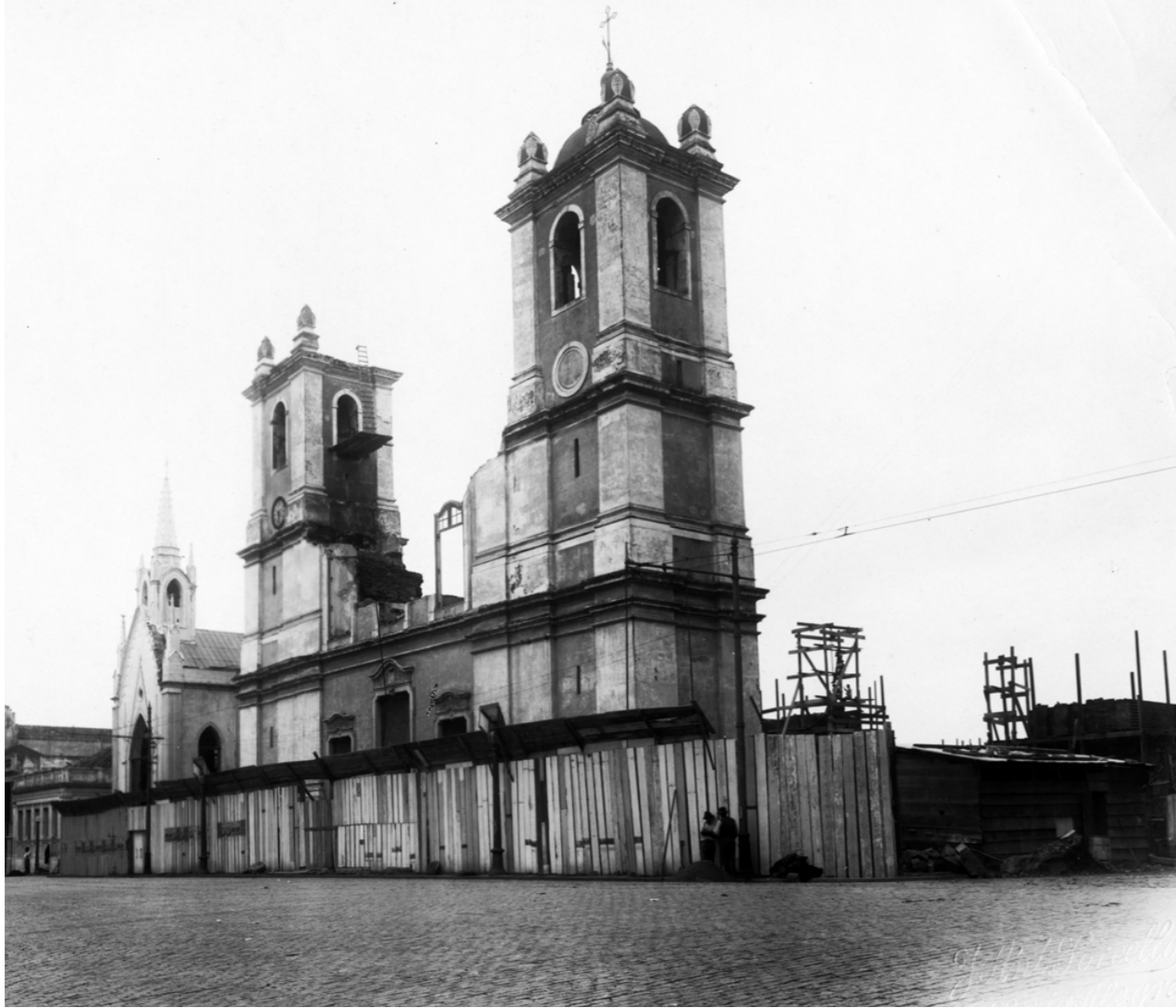
▲ ► Foto 7, 8, 9. [10/1929] Processo de demolição da antiga matriz e da capela do Divino Espírito Santo, coordenado pelo mestre de obras José Brunelli, que deu lugar, em toda sua extensão, à nave e às torres da Nova Catedral.
