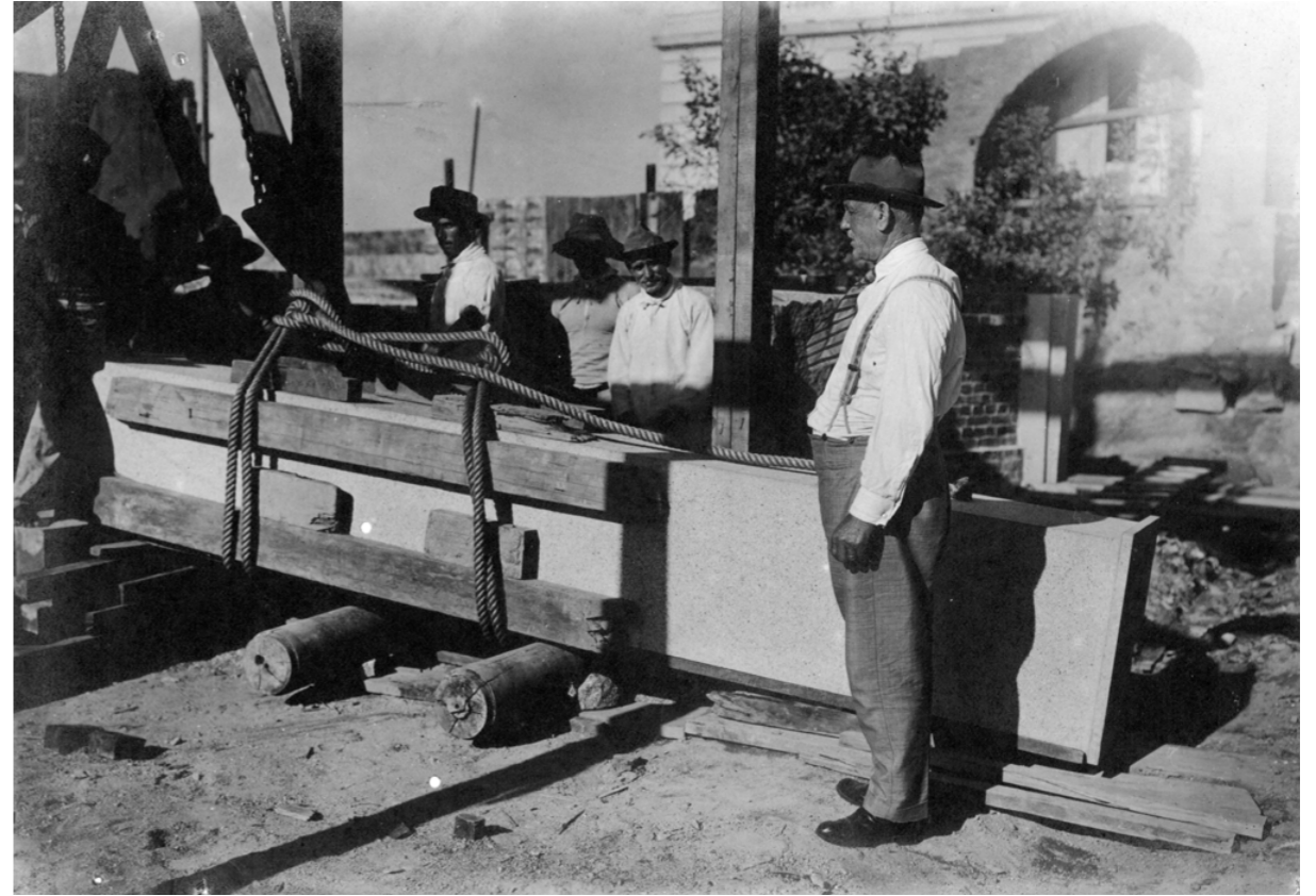
▲ Foto 38. Pilastra da cripta sendo erguida com o auxílio de cabos e toras de madeira. O serviço é acompanhado por Brunelli.
