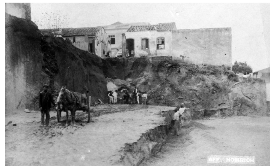
▲ Foto 40. [ca. 1921] Terreno já recortado e parcialmente aplainado. Ali os operários trabalhavam na remoção de um patamar de terra. Ao fundo, casas de meia morada, exemplares da arquitetura luso-açoriana do século XVIII.
