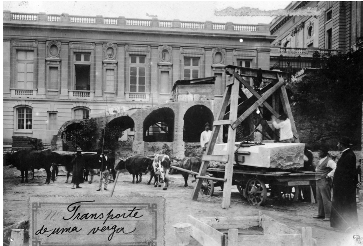
▲ Foto 33. Içamento do bloco de granito pela talha-patente, enquanto os bois que puxavam o carretão aguardam, com seus guias ao lado. À direita, Mons. Balem e José Brunelli; de pé, e de frente para a foto, Luiz Marques, pedreiro português.
