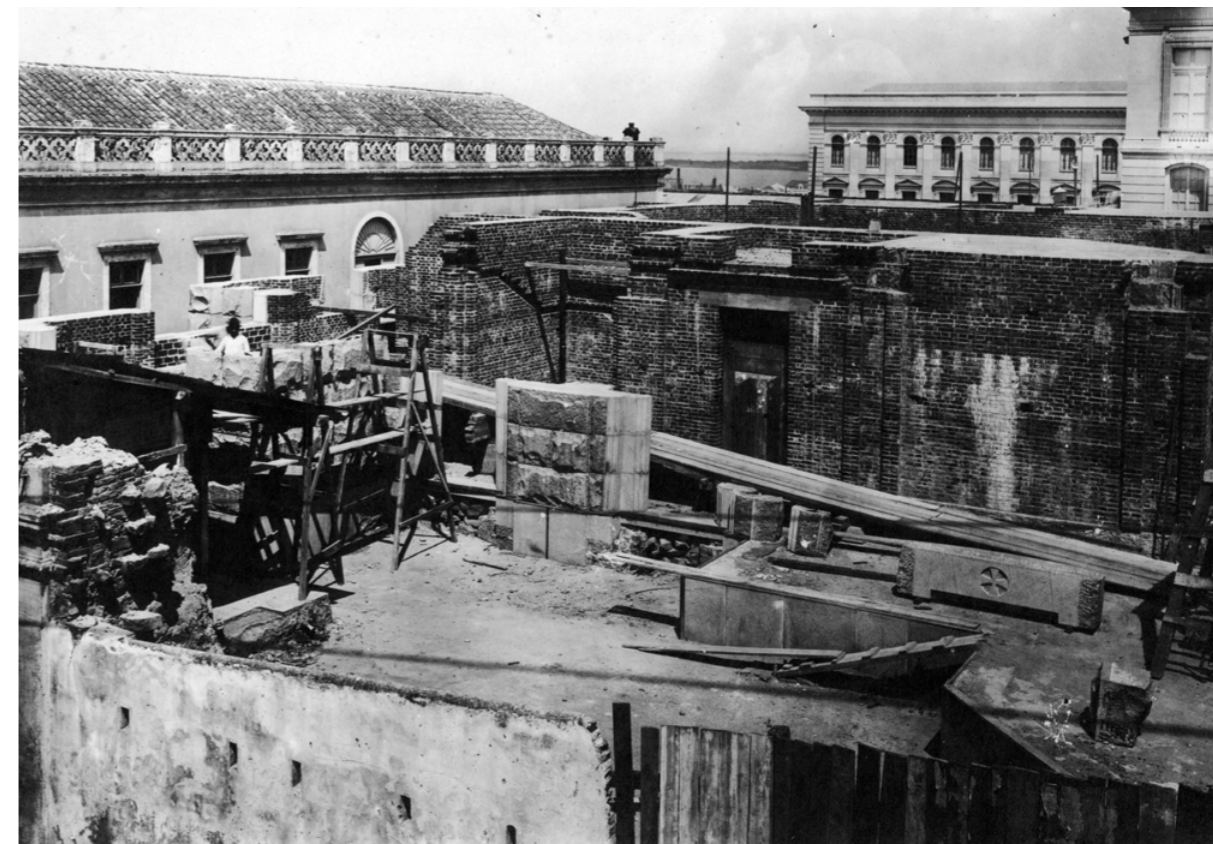
▲ Foto 52. [1924] O muro dos fundos do antigo Seminário se dispõe em primeiro plano. Ao longe, avista-se o Guaíba. As paredes de tijolo conferiam à obra os ares do progresso, enquanto os blocos de pedra já começavam a ocupar seus lugares.
