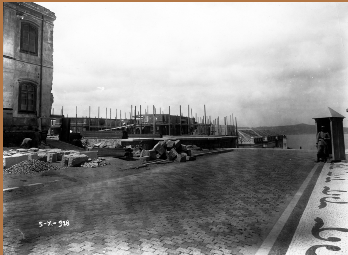
▲ Foto 63. Em uma cidade sem torres de edifícios, do alto da matriz, o lago Guaíba com a enseada de Belas, posteriormente aterrada, era avistado no horizonte. As obras seguiam lentamente, sobre a cripta concluída subiam os pilares da cúpula, em alvenaria de tijolos e concreto.
