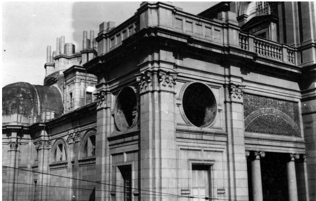
▲ Fotos 99 e 100. [ca. 1947] Catedral parcialmente concluída para a inauguração provisória.
