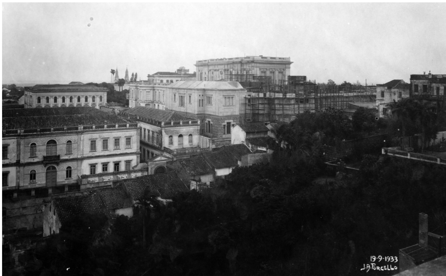
▲ Foto 82. As obras e seu entorno, em fotografia tirada no antigo Colégio Anchieta. Em primeiro plano, declive do terreno, revelando os fundos do Museu Julio de Castilhos, e residências do Dr. Borges de Medeiros e do Dr. Plínio Casado. Coberto de andaimes, pouco se denota do prédio da Catedral que estava sendo erguido, a não ser a parte sul da cripta. Na sequência, à esquerda, a Cúria Metropolitana e, atrás, o Colégio Paula Soares. O Palácio Piratini já tinha seu espaço definido. A seu turno, as torres (as da igreja das Dores) e a casa do Dr. Adroaldo Mesquita da Costa encerram o rápido olhar da imagem.
