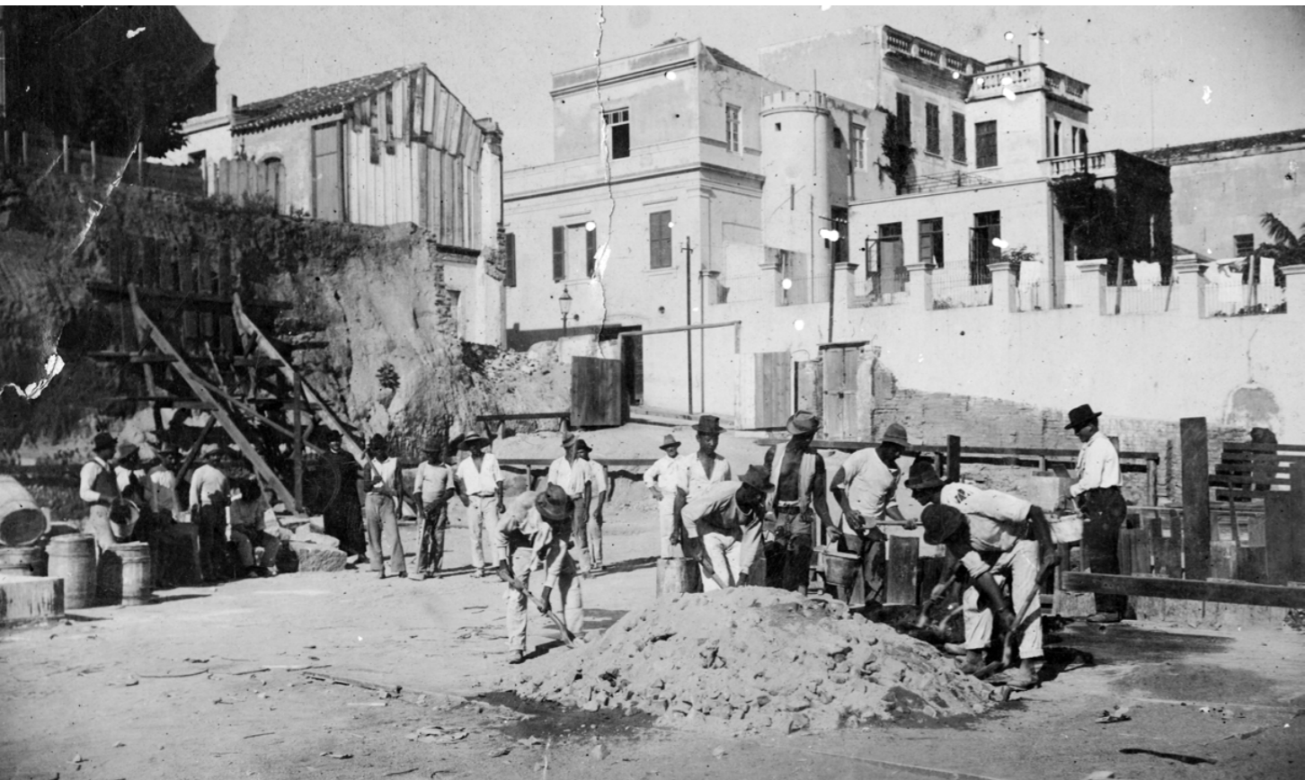
▲ Foto 41. [1921] Preparação da argamassa, possivelmente para a construção do arrimo, cujo barranco foi escorado com mãos francesas e tábuas de madeira.
