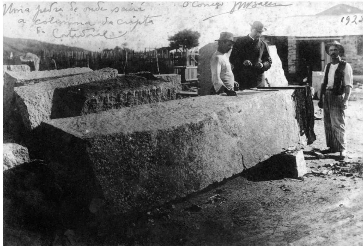
▲ Foto 123. Bloco de pedra onde será esculpida uma das colunas da cripta. Na foto aparecem Luiz Tamanini (1º capataz da pedreira), Mons. Balem e Pedro “canteiro”.
