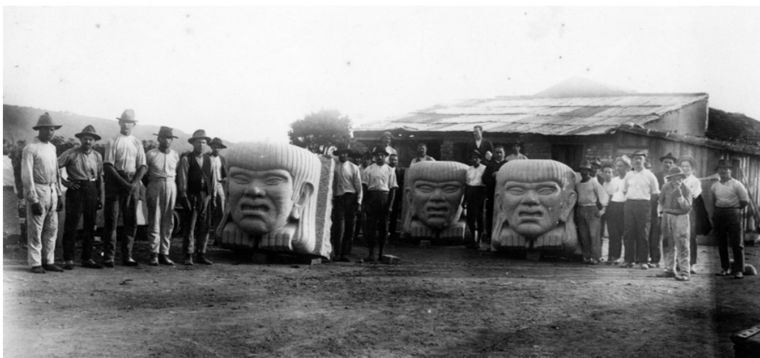
▲ Foto 122. Equipe de canteiros posam com Mons. Balem entre as misulas de sustentação das absides da Catedral.
