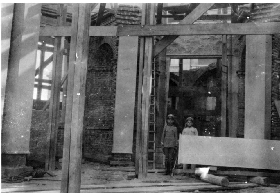
◀ Fotos 54 e 55. Colocação ▼ das pilastras de grani- to no interior da cripta (rua Dom Sebastião).
