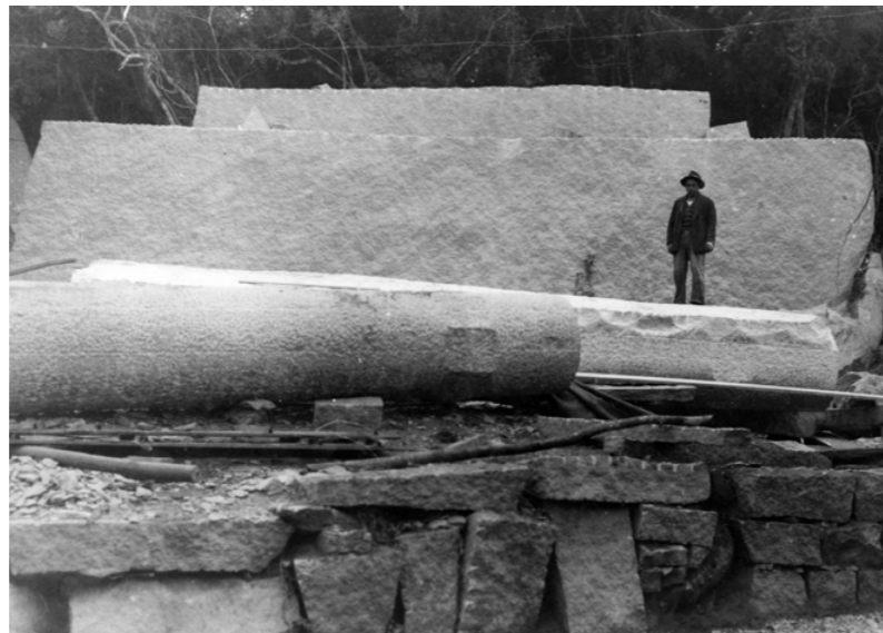
► Foto 124. A transformação da pedra, que passa de grande monólito a colunas e blocos de revestimento.
