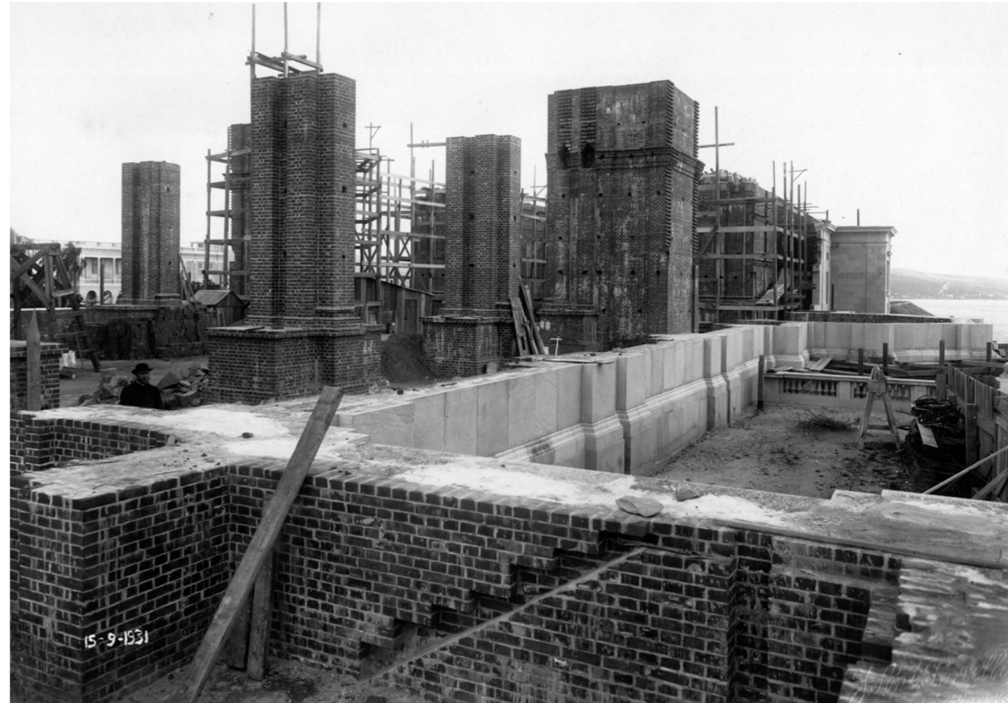
▲ Foto 78. Mesmo com a redução de operários e as poucas arrecadações, as obras continuaram. Em primeiro plano, a construção da torre oeste, com sistema construtivo misto (alvenaria de tijolos, concreto e placa de pedra), e a espera para o engaste da escadaria em concreto armado, com a função de dar acesso ao compartimento do sino. Em segundo plano, a elevação das capelas intercomunicantes da nave em alvenaria de tijolos.
